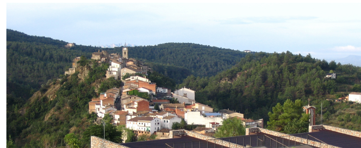
El pas per Santa Maria d'Oló es farà en túnel
