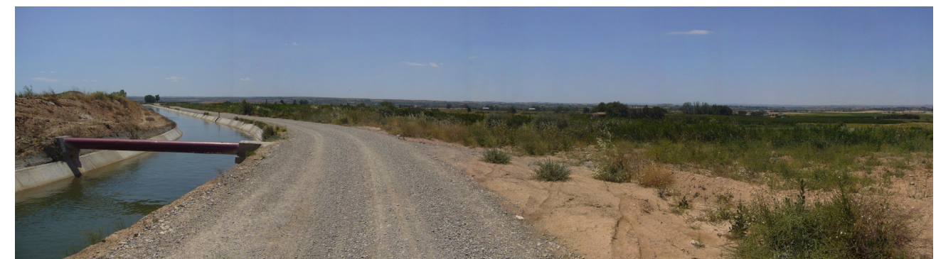
Canal auxiliar d'Urgell a proximitat immediata del pas de la N-240
